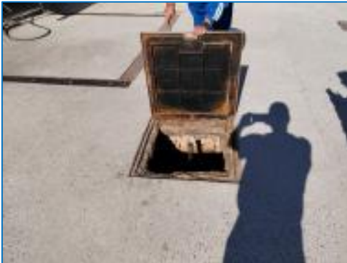
Arqueta tanque 1 - vista general
