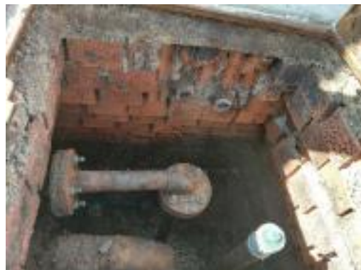
Arqueta tanque 2 - estado interior
