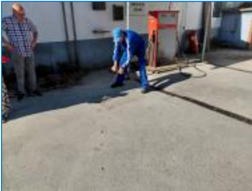
Arqueta tanque 2 - vista general
