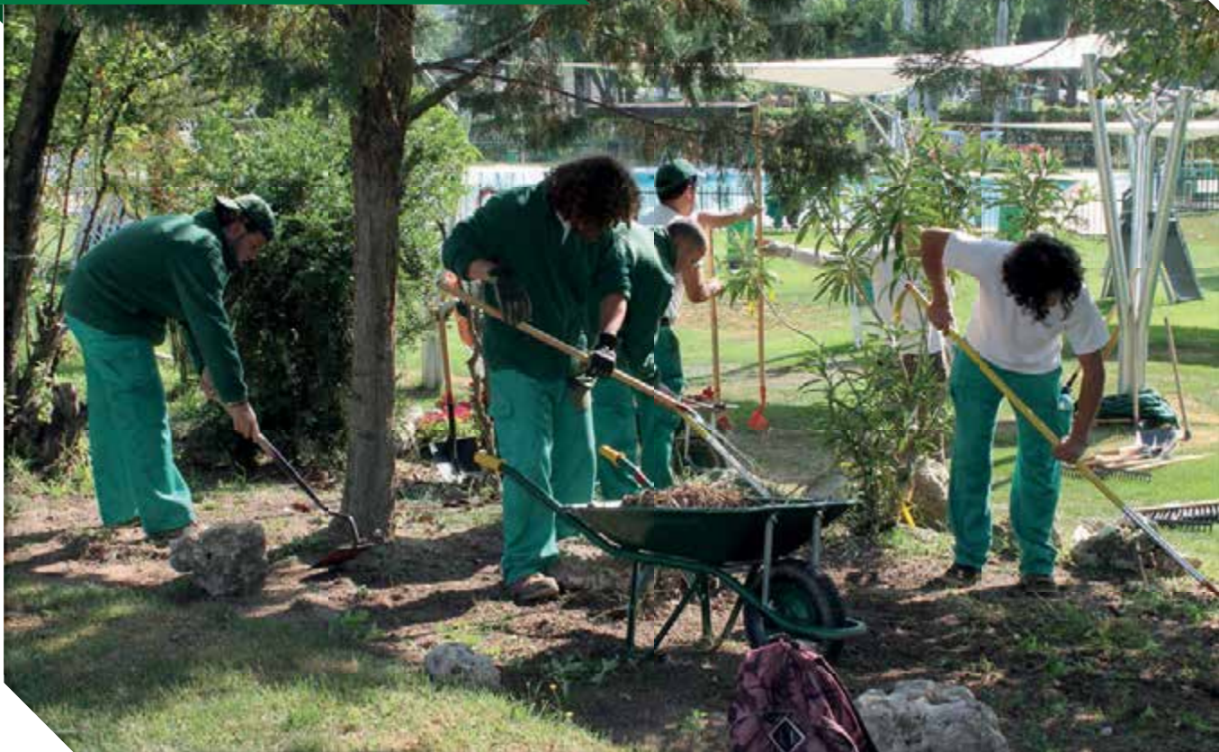
Acondicionamiento del área de piscinas de verano
